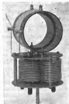
Neutro trasformatore e condensatore di sintonia.
